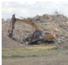
Demolición o restauración
